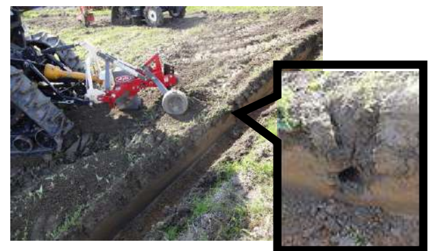
写真 額縁排水溝に連結した暗渠
