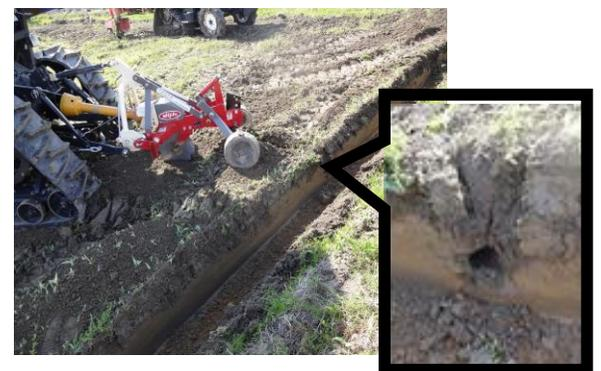
写真 額縁排水溝に連結した暗渠
